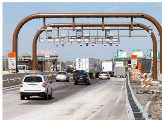
アンテナ(E-ZPass 通信)、 車両検知器で車両前後のプレートを撮像
