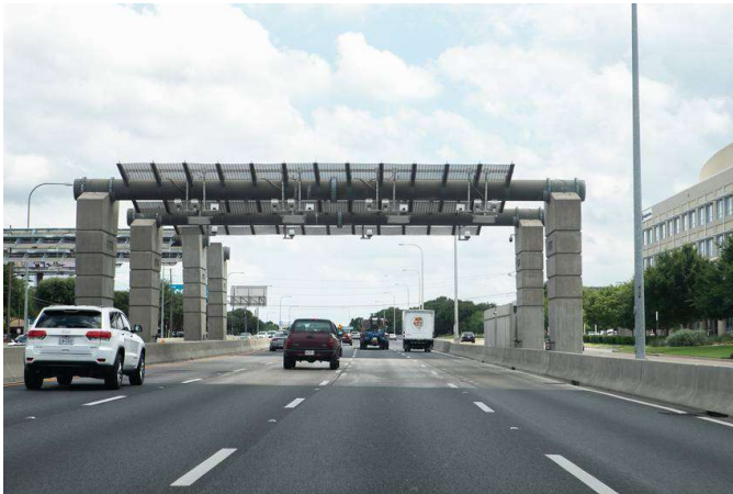
図 3-2 テキサス州のマルチレーン・フリーフローAET
