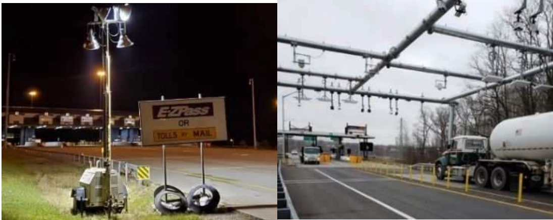
図 3-14 キャッシュレス工事の進捗状況 (2020/7/6 時点)と開通時(2020 年 11 月 14 日)
