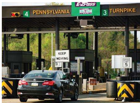
アンテナ(E-ZPass 通信)、 車両検知器(S4)で車両前後のプレートを撮像
